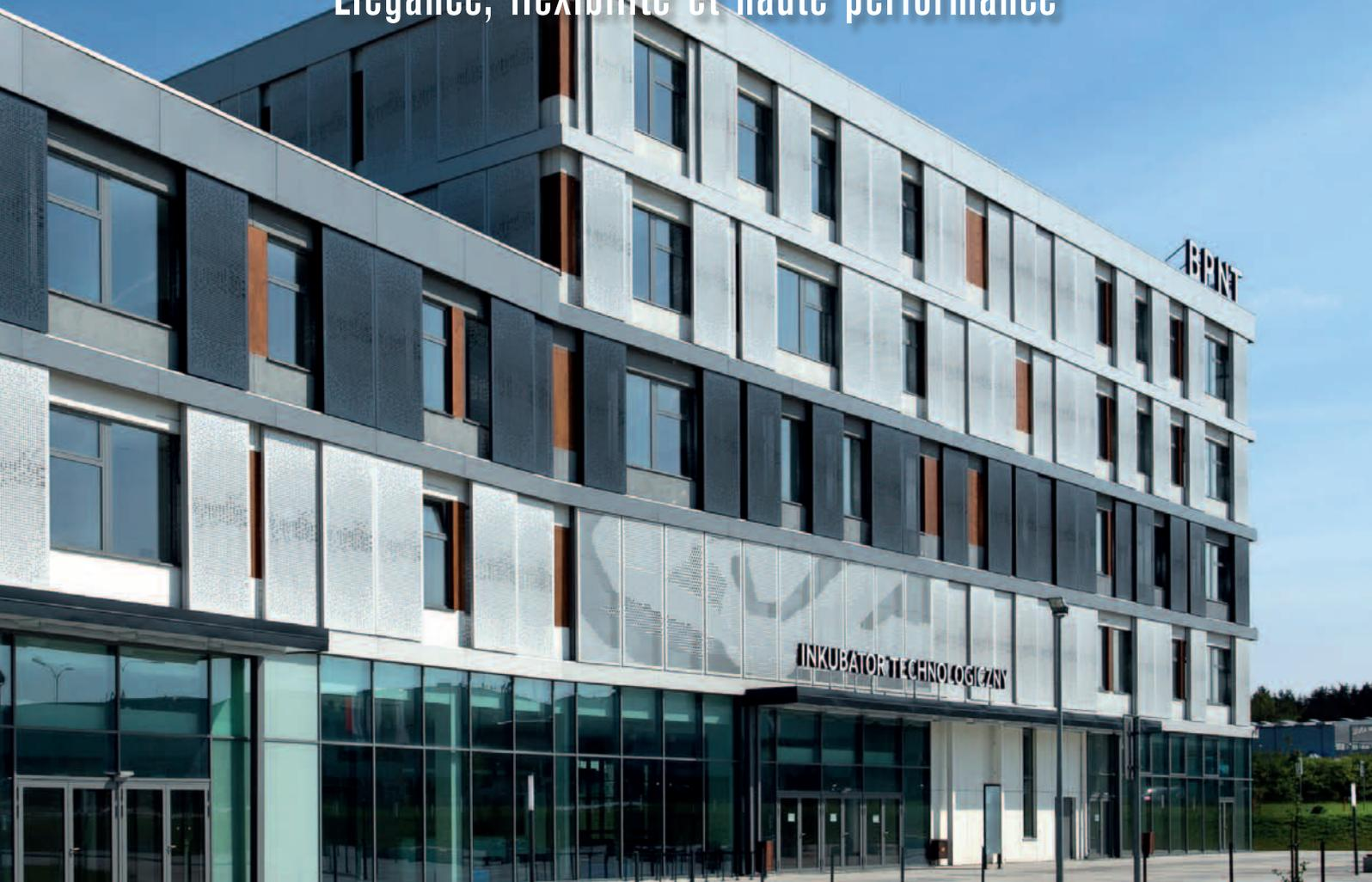
Le panneau coulissant sans cadre de HunterDouglas® est proposé avec un choix de deux perforations : 5% ou 10% d'ouverture afin d'avoir le meilleur confort intérieur, visuel et thermique. Les panneaux d'aluminium peuvent être laqués dans n'importe quelle couleur disponible, résultant en un volet résistant aux conditions météo. Pour encore plus de flexibilité de conception, des perforations ou modèles personnalisés peuvent être appliqués.
