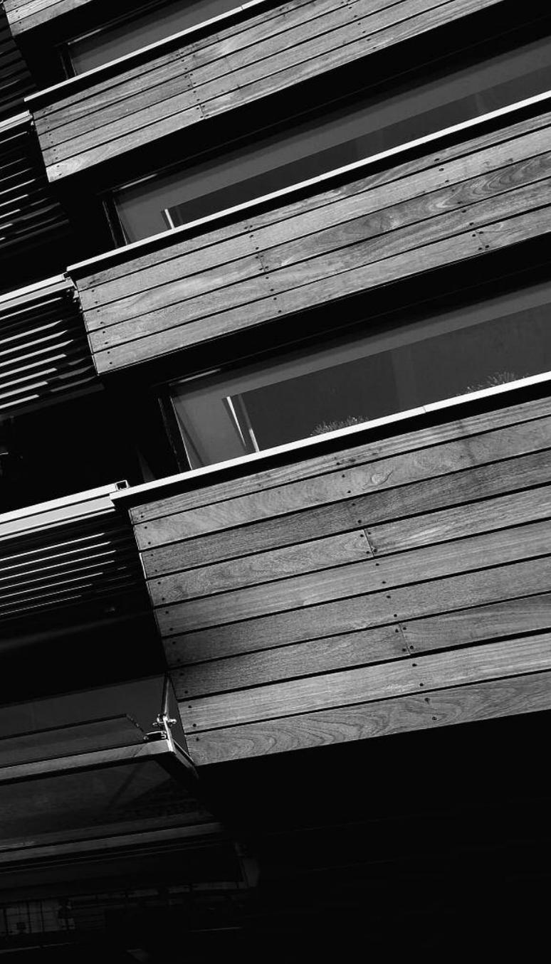
Tous les systèmes linéaires - 84R, 70S/132S, 100R et 110HC - sont composés de lames simple peau extrudées ou en feuillard profilé, ils sont totalement disponibles avec différentes structures de support. Les projections horizontales et verticales sont proposées dans diverses applications afin de répondre aux spécifications et au concept chaque projet.
