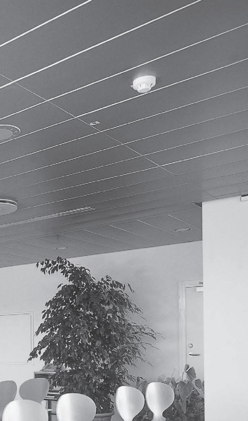
El ancho de nuestro panel es de 300 mm y el largo se puede fabricar variable desde 1 hasta 6 m, lo que permite establecer el largo idóneo del panel en cada área en función de la modulación del edificio.
