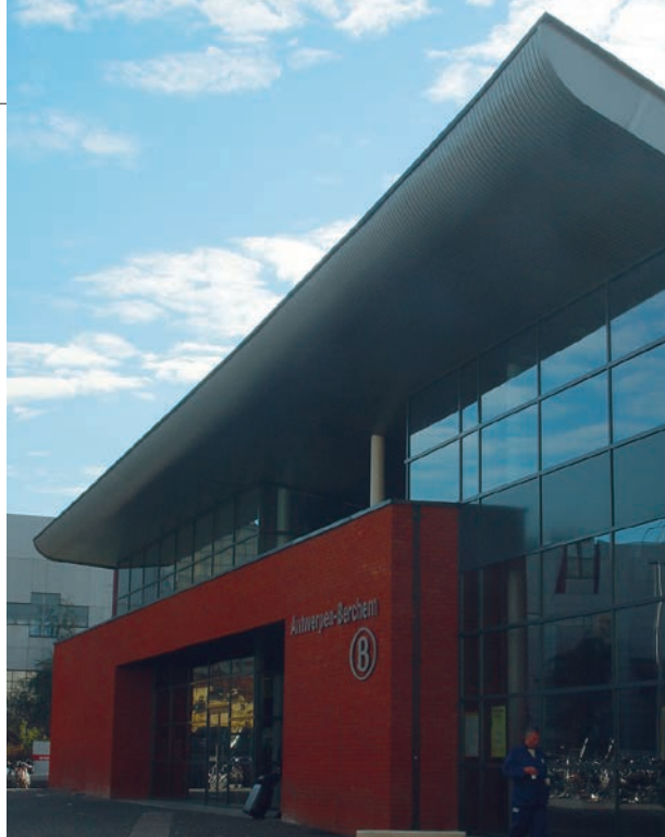
Ci-dessus : Gare ferroviaire d'Anvers Berchem, Anvers, Belgique Produit : 84R Extérieur Architecte: NMBS (NL), SNCB (FR)
