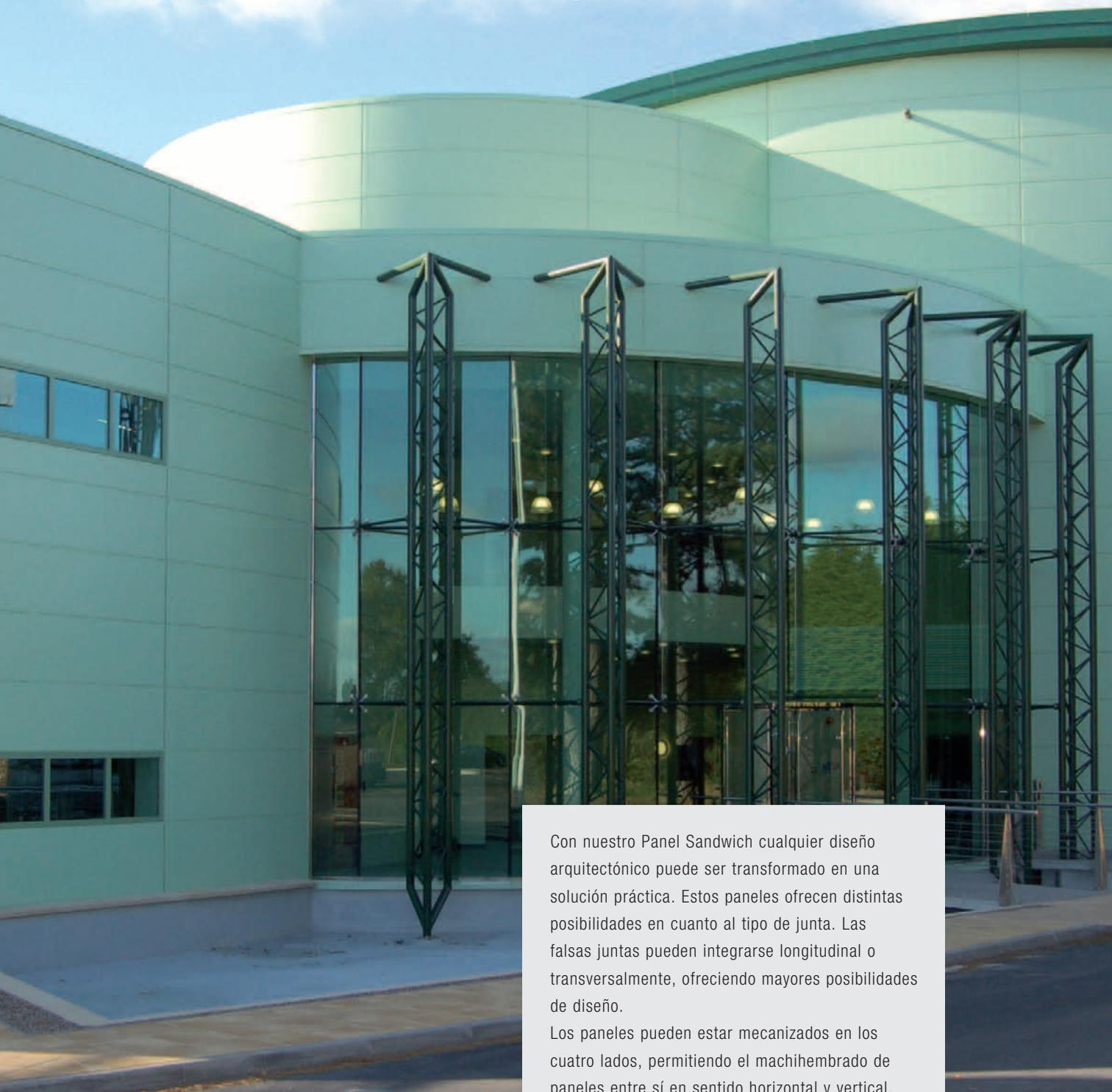
Con nuestro Panel Sandwich cualquier diseño arquitectónico puede ser transformado en una solución práctica. Estos paneles ofrecen distintas posibilidades en cuanto al tipo de junta. Las falsas juntas pueden integrarse longitudinal o transversalmente, ofreciendo mayores posibilidades de diseño.
