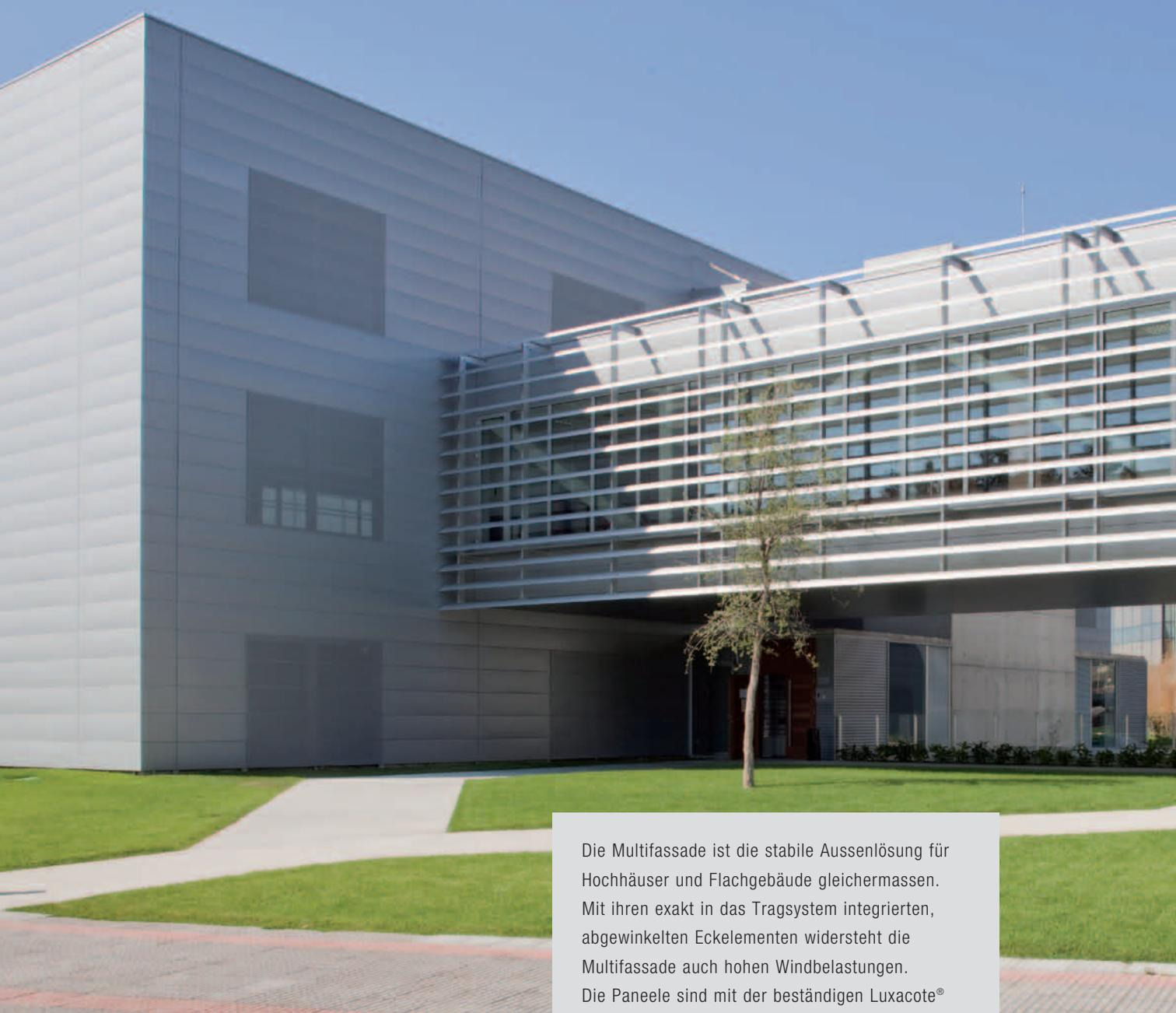
Die Multifassade ist die stabile Aussenlösung für Hochhäuser und Flachgebäude gleichermaßen. Mit ihren exakt in das Tragsystem integrierten, abgewinkelten Eckelementen widersteht die Multifassade auch hohen Windbelastungen. Die Paneele sind mit der beständigen Luxacote® Beschichtung überzogen, die in vielen Farben erhältlich ist und Schutz gegen Korrosion, Kratzer und UV-Strahlen bietet.
