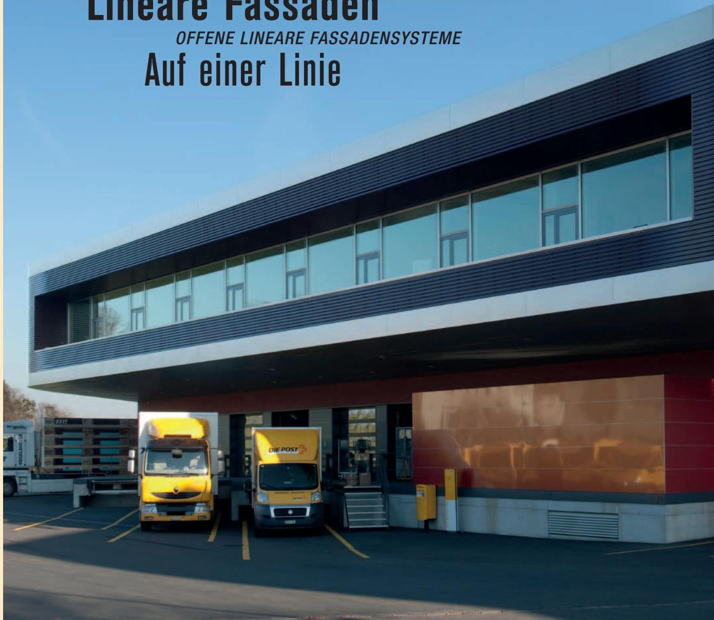
Ein System, vielfältig wie kein zweites. Lineare Fassadensysteme können als Fassaden, Belüftungsgitter oder Sonnenschutzsysteme verwendet werden. Die Aluminiumpaneele sind sehr leicht und dank der integrierten Tragstruktur sowohl horizontal als auch vertikal montierbar. Ob als Fassade, als Abschirmung für 'offene' Treppenaufgänge oder als Belüftungszaun, unsere linearen Paneele sind stets funktional und sehen immer gut aus.
