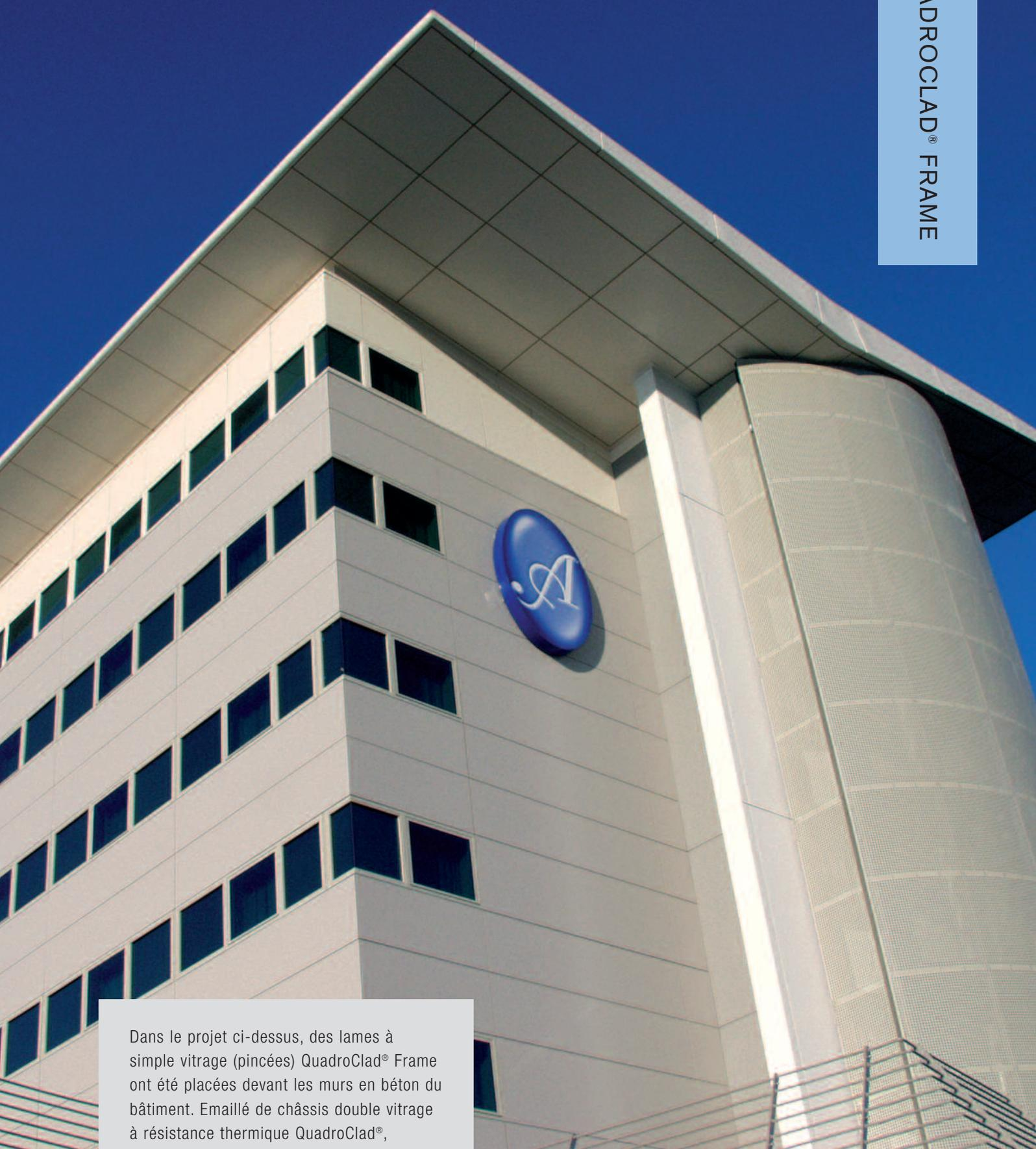
Dans le projet ci-dessus, des lames à simple vitrage (pincées) QuadroClad® Frame ont été placées devant les murs en béton du bâtiment. Emaillé de châssis double vitrage à résistance thermique QuadroClad®, QuadroClad® Frame a permis de créer un ruban de verre continu autour du périmètre du bâtiment.
